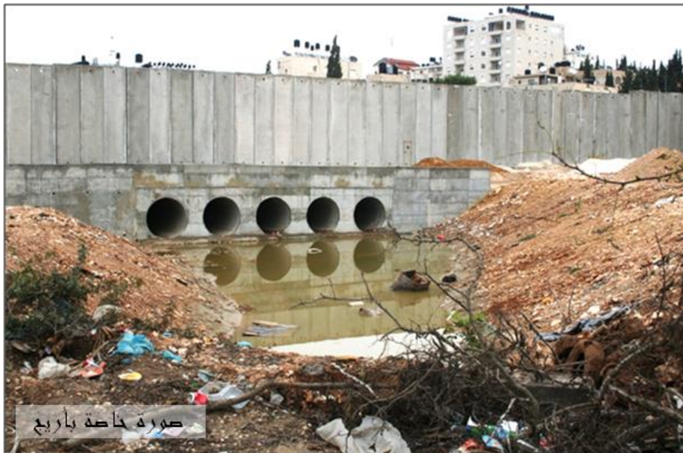
صورة 2: إنشاء الجدار فوق خطوط شبكة الصرف الصحي
