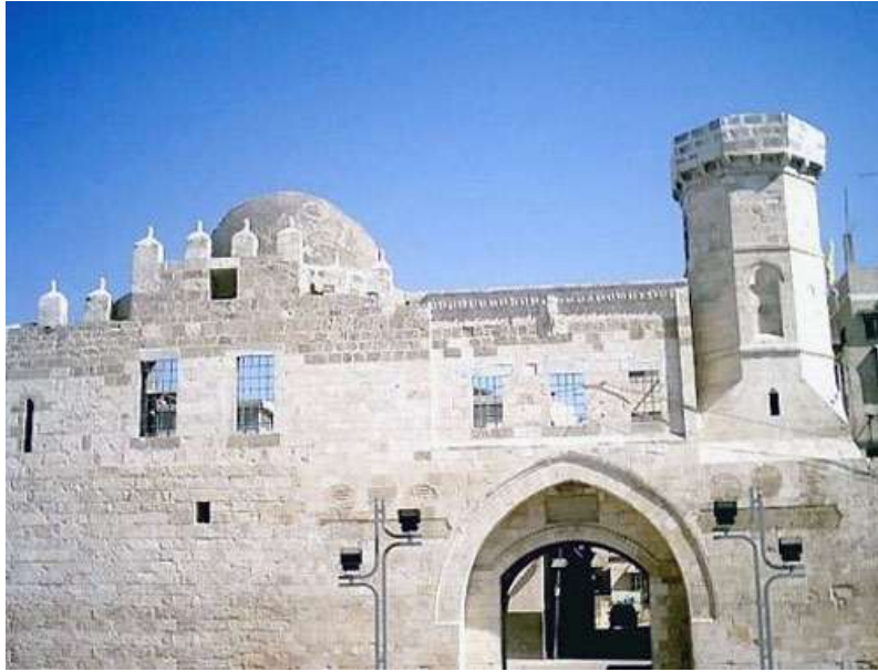
صورة لقلعة برقوق
